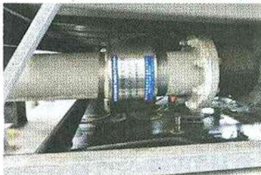
屋上の冷却水配管に設置(左)と地下機械室の冷温水配管に設置された「パイプテクター」(右)
