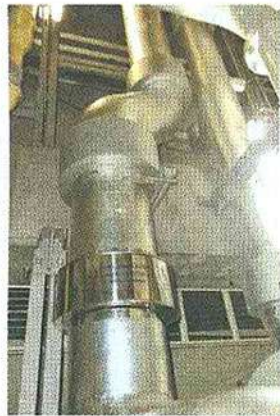
屋上の冷却水配管に設置(左)と地下機械室の冷温水配管に設置された「パイプテクター」(右)
