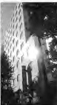
国内のホテル、旅館でもNMRパイプテクターの導入が始まった（写真は東京のホテルサーブ渋谷）
