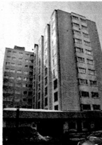
2004年に外断熱改修を行った札幌市中央区のマンション。管理組合によると、冬場の暖房費は平均32%減少したという
