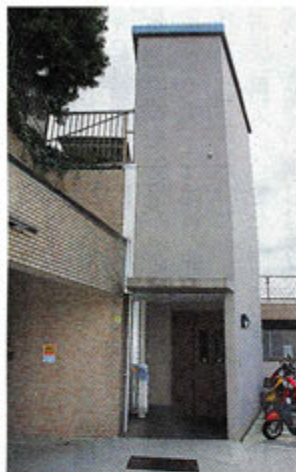
パイプテクターの新設ができた
