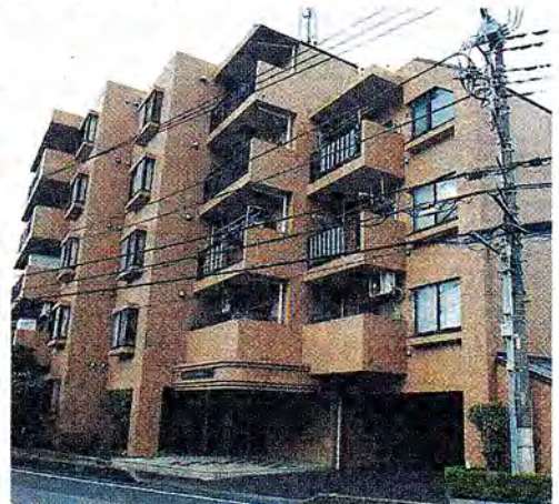
NMRパイプテクターを導入して、この11月で6年が経過する「ライオンズマンション越谷北」
