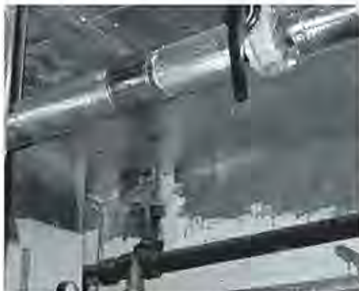
写真3 アデンブルックス病院 NMRパイプテクター設置箇所
