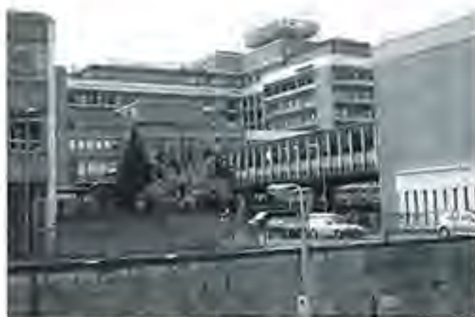
写真1 アッデンプルックス病院 建物概観
