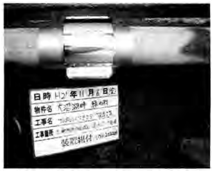
NMRパイプテクターの設置例
