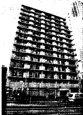
冬場の漏水もなくなった「カイサ土佐堀」
