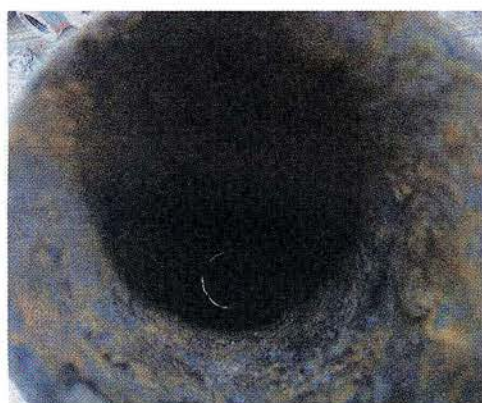
高築水槽2次側給水管。赤錆び化は見られず閉塞もなし
